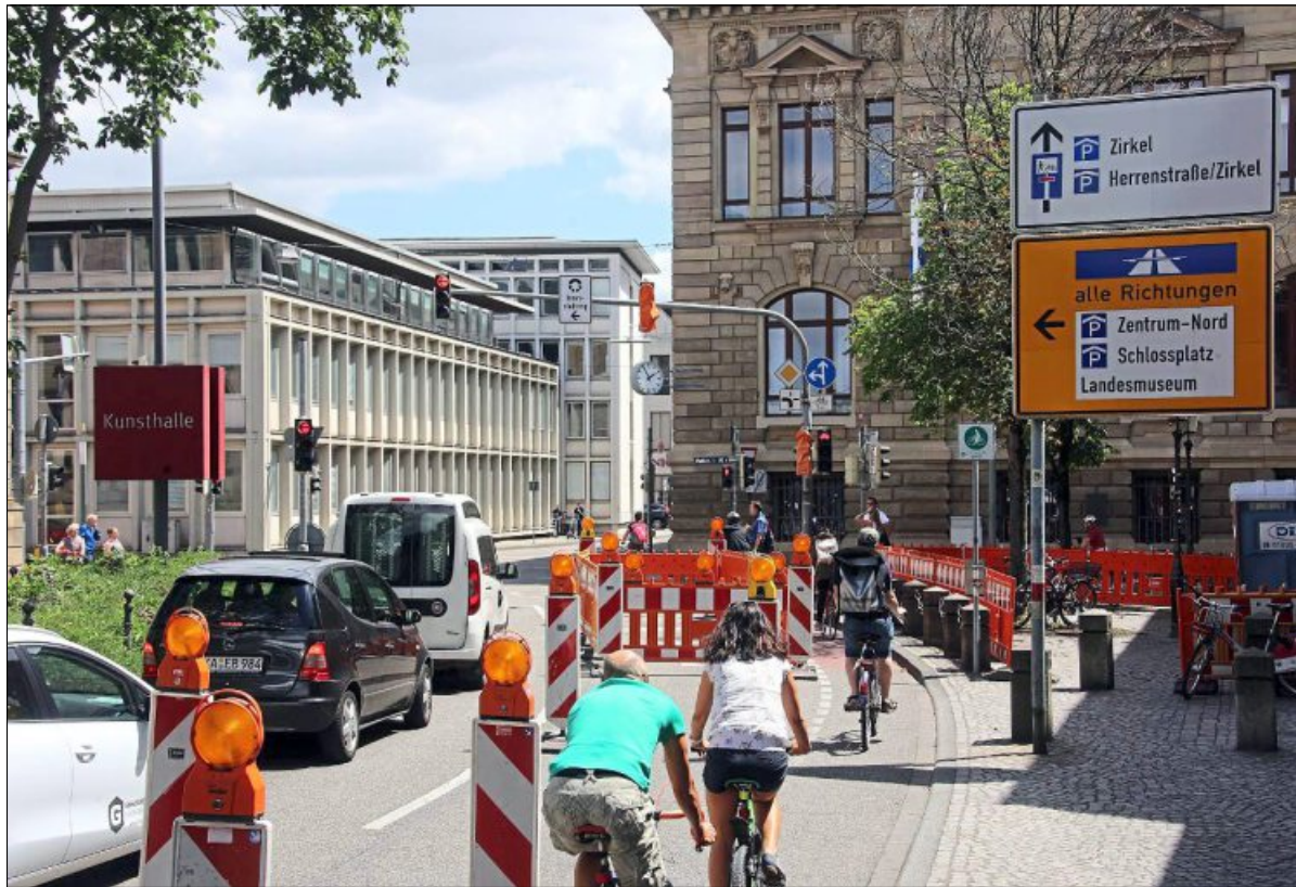
Faktischer Test: Wo die Waldstraße in die Hans-Thoma-Straße mündet, hätte ein Pop-up-Radweg für Autofahrer ähnliche Auswirkungen wie die aktuelle Baustelle. Wegen Fernwärmearbeiten gibt es nur eine Spur für Autos.
