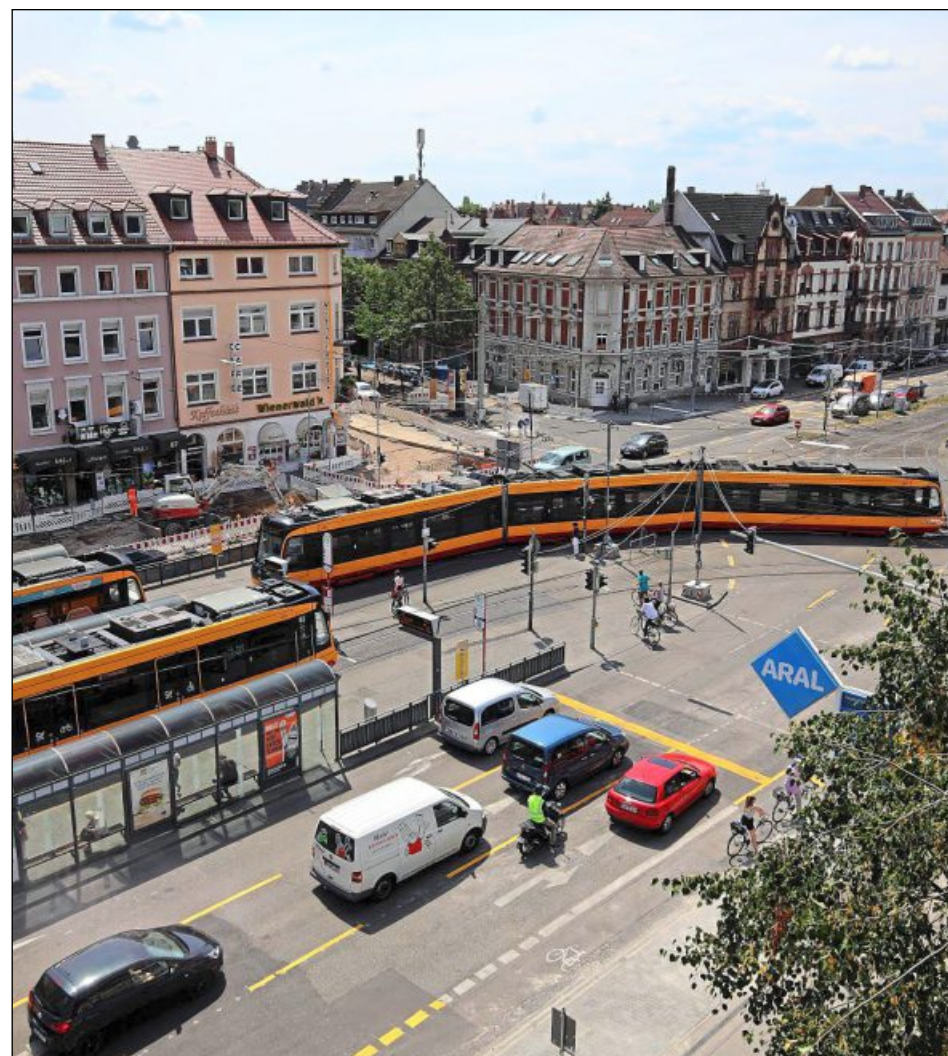
Vor dem großen Umbau: Die Haltestelle „Yorkstraße“ in der Kaiserallee wird in den Sommerferien in eine barrierefreie Station umgewandelt. Foto: Jörg Donecker
